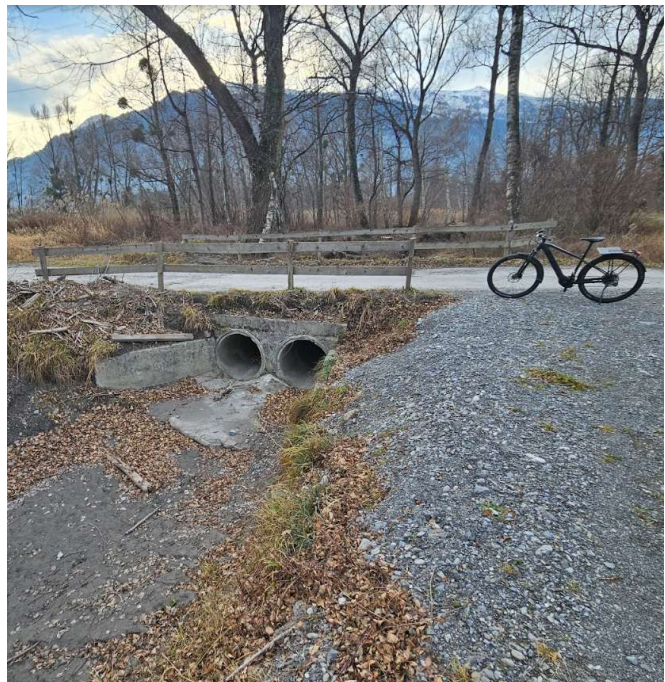
Rohrbrücke über die Feldrüfi:
